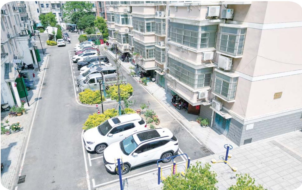
改造完成的振亚华门小区。
