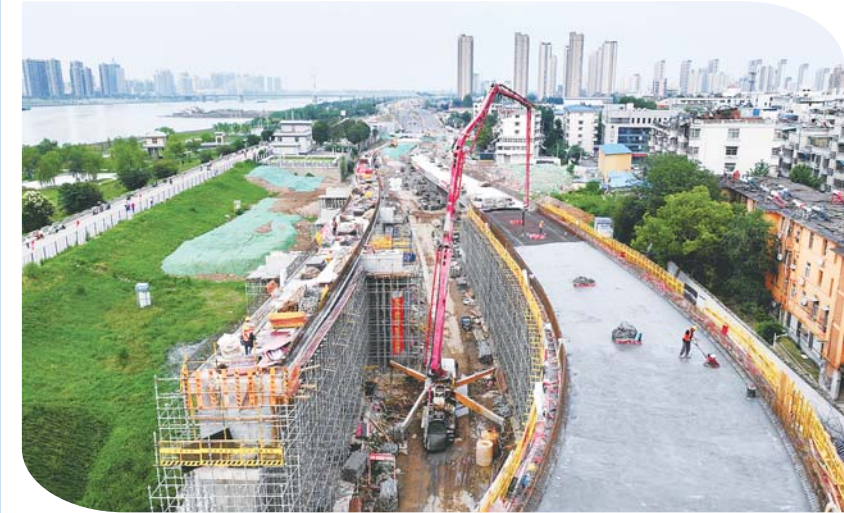
6月3日傍晚,延安路淮河大桥及接线工程南岸现场,C匝道最后一联现浇箱梁顶板正在浇筑。待当日浇筑完成后,项目将转入南岸主线引桥施工。据介绍,为给中高考创造有利环境,项目调整施工计划,南岸主线引桥承台、墩柱施工调整至6月下旬开始。 融媒体记者 刘晨 摄
