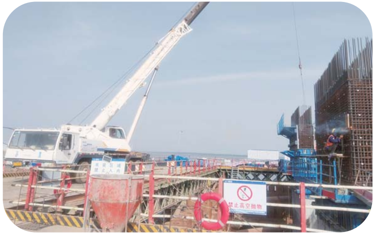
项目施工现场。
