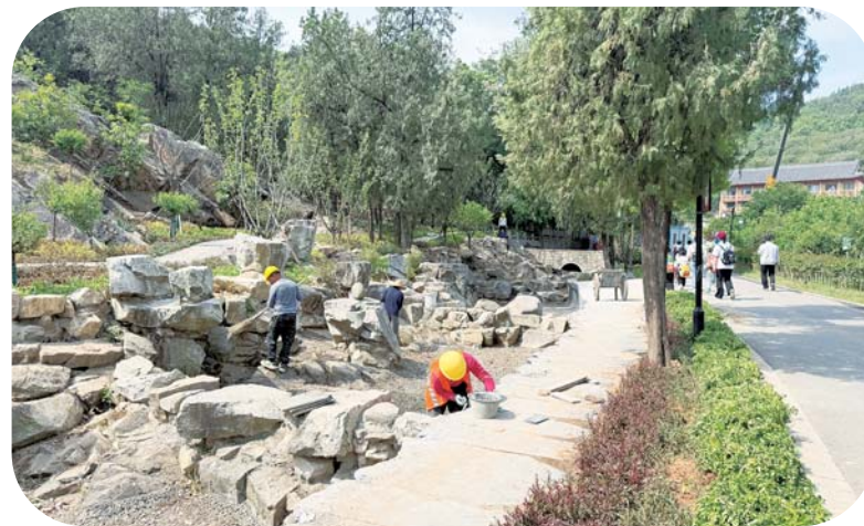
施工人员进行梅子涧。
