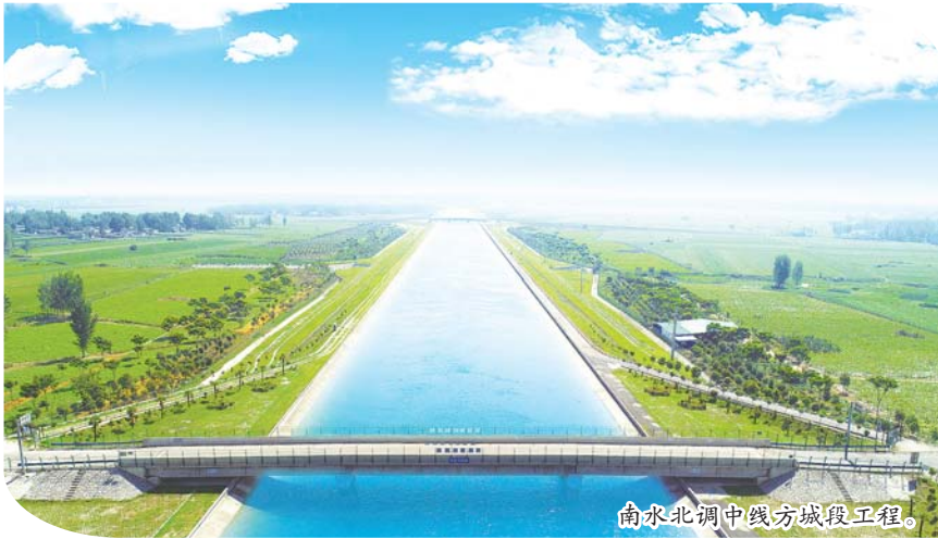
南水北调中线方城段工程。
