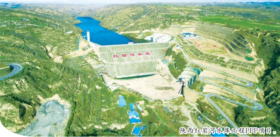
陕西红岩水库工程PPP项目。
