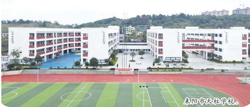
耒阳市天柱学校。
