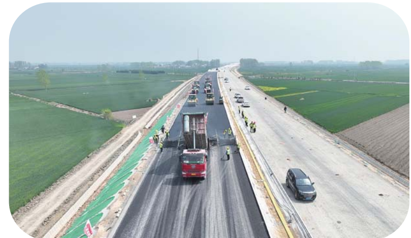
五蒙高速公路固镇段项目施工现场。
