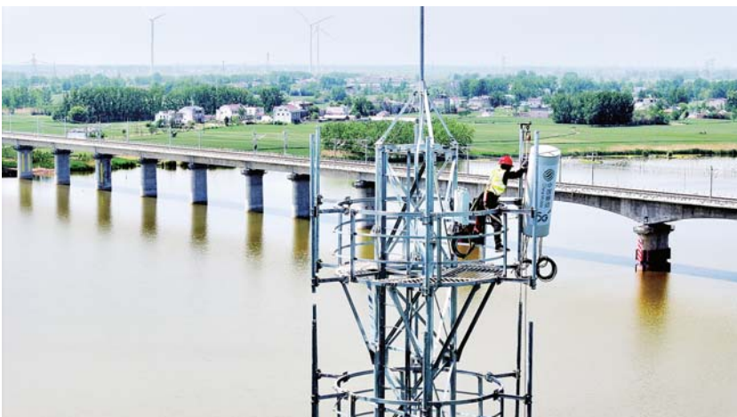
蚌埠移动施工人员对高铁专网主设备、天线进行吊装（无人机照片）。
