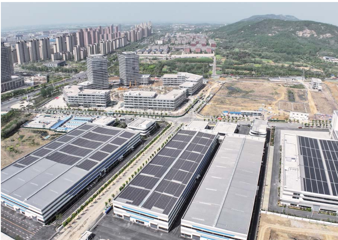
4月17日,中国·蚌埠商业航天产业园全面进入收尾阶段。融媒体记者 陈昂 摄
