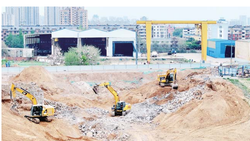
“蚌埠船厂旱闸”迁移异地保护工程现场,挖掘机在对原旱闸混凝土结构进行拆除。
