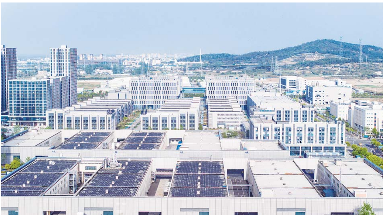
4月13日,宁波蚌埠微电子产业园(无人机照片)。该产业园正全力打造国内一流的智能传感器专业化园区。
