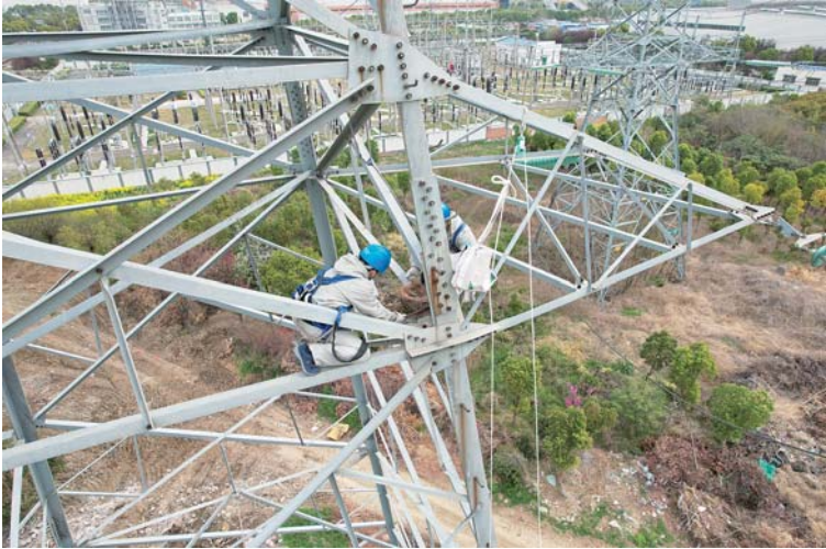
带电迁移作业。国网蚌埠供电公司人员对鸟巢进行
