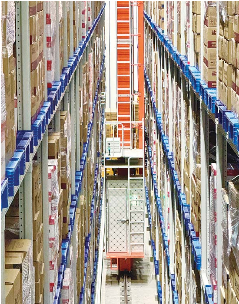
存储量达8000吨的无人立体库。
