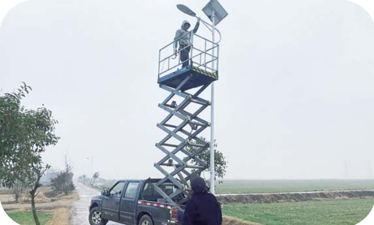
日前，五河县新集镇马桥村针对群众反映的郭楼、马东两个自然庄部分路灯损坏，希望在某些地段安装路灯的情况后，对损坏的16盏路灯进行维修替换，并安装8盏太阳能路灯，方便群众出行。
