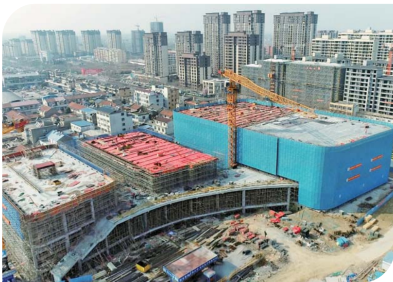
固镇体育场改造提升项目现场。
