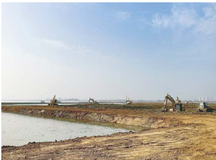
2月28日，龙子湖西南片区生态综合治理工程正式开工建设。
