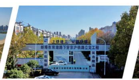
小蚌埠片区双墩路下穿京沪铁路立交工程
