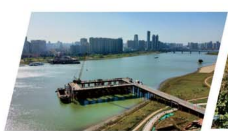
延安路淮河大桥建设有序进行
