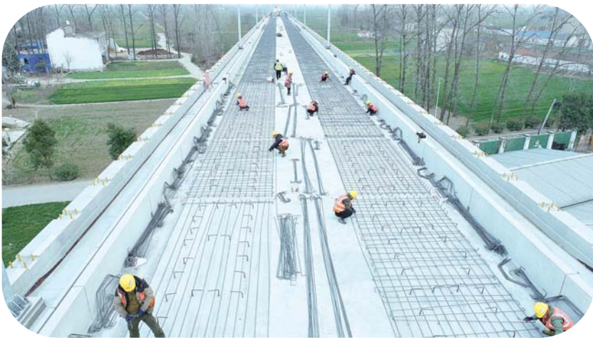
淮宿蚌城际铁路固镇段固镇西特大桥项目施工现场。
