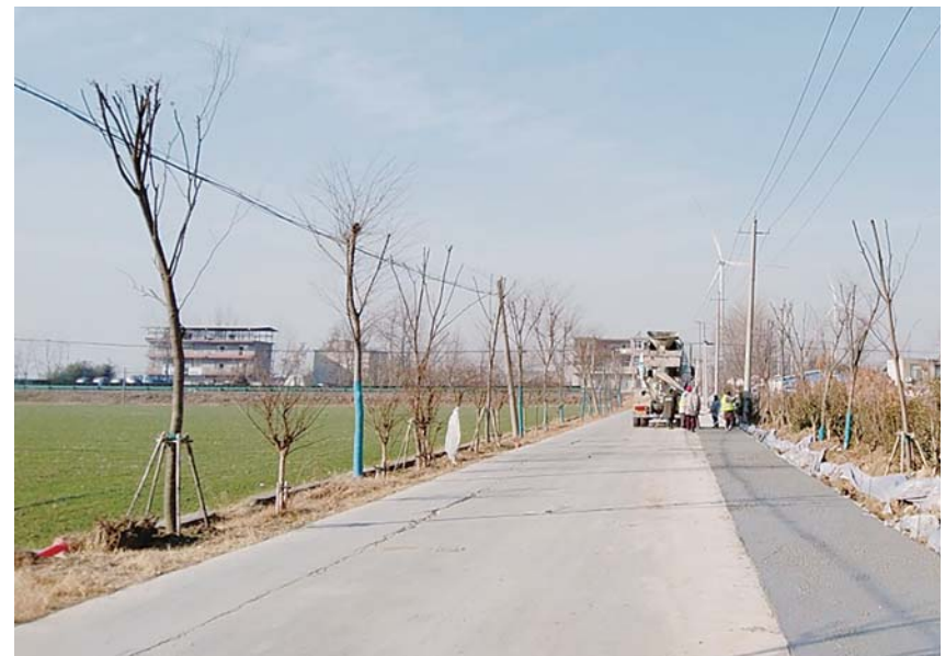
近日，五河县“四好农村路”建设工作加紧进行。
