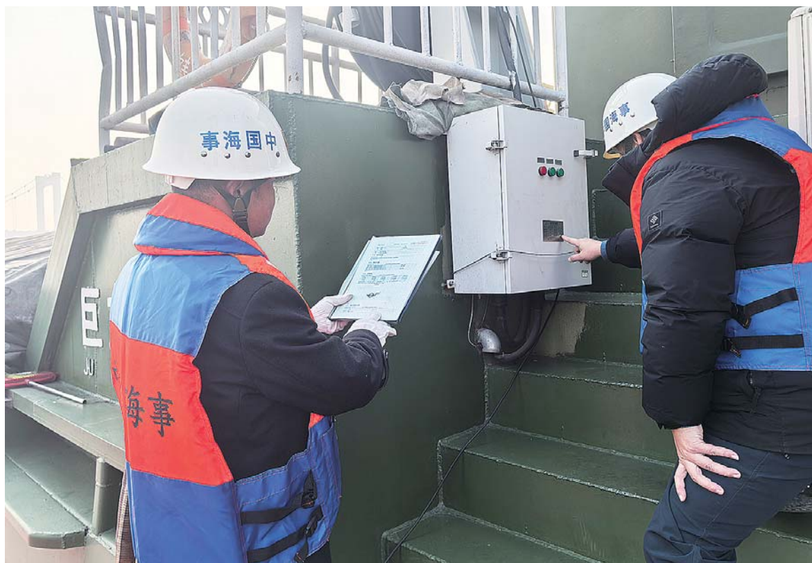
海事人员进行岸电设施改造工作。
