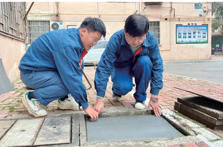
中环水务工作人员对供水设备进行防冻检查。
