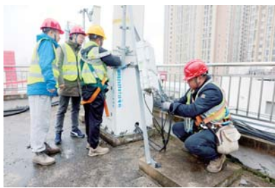
1月24日,蚌埠移动公司网络部工作人员在高空进行通信设备安装调试。
