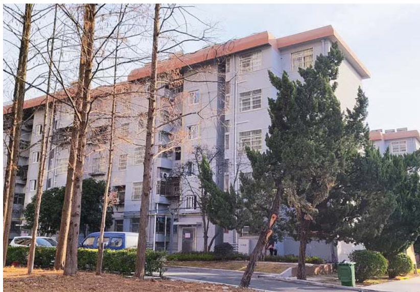
燕山路1053号院改造一新。新增光纤入户等基础改造。按照居民们的意愿，老旧小区还进行了违建拆除、节能照明设施改造，适老化、无障碍设施改造，新增地面停车位、非机动车充电桩，新增智能快递柜，新增文化休闲、体育健身、公共绿地等改善提升改造，还有部分小区新增了安防智能感知设施。
