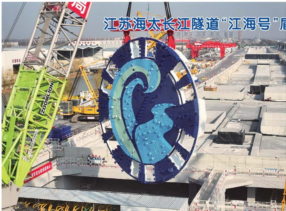
1月22日拍摄的“江海号”盾构机刀盘装下井作业现场（无人机照片）。
