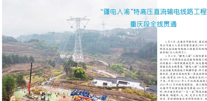
1月8日,在重庆市渝北区,重庆送变 电公司施工人员在哈密至重庆±800千伏 特高压直流输电线路工程重庆段现场施 放导线(无人机照片)。
