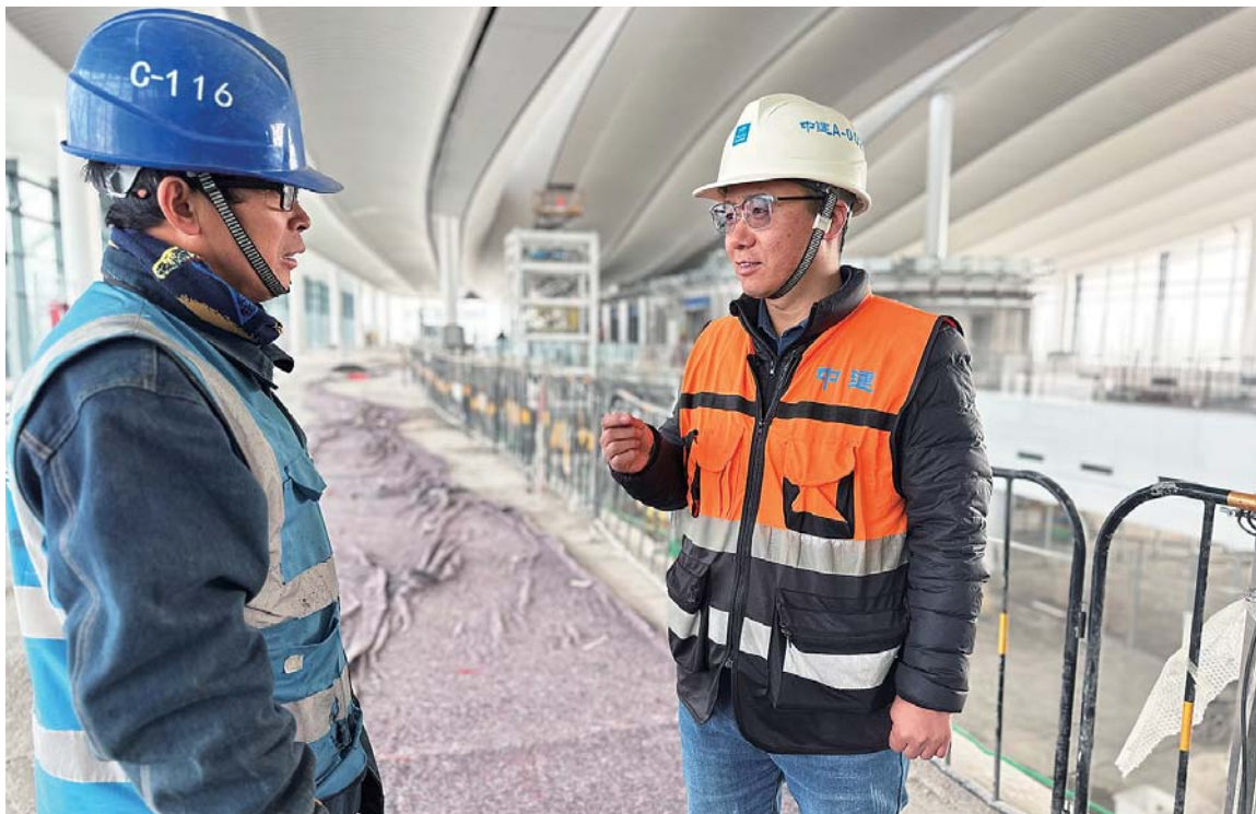
李州(右)与施工人员进行沟通交流。
