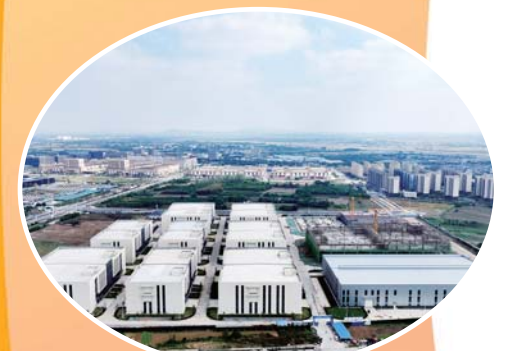
正在建设的蚌埠综保区。
