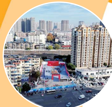
2024年12月8日,蚌埠市解放二地下穿铁路工程暨胜利二村片区城市更新项目开工。
