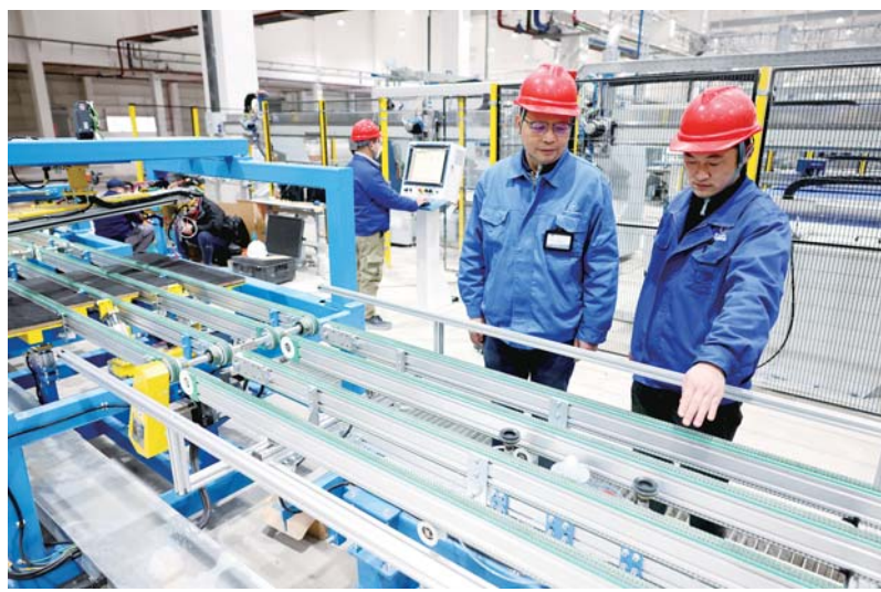
日前,安徽武耀汽车玻璃有限公司项目设备负责人尤磊询问生产线安装情况。
