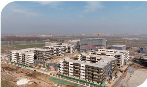
建设中的五河一中新校区。
