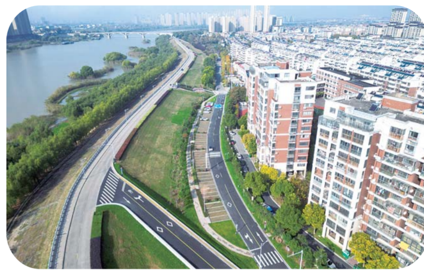
提升改造后的涡淮路及涡河沿岸。
