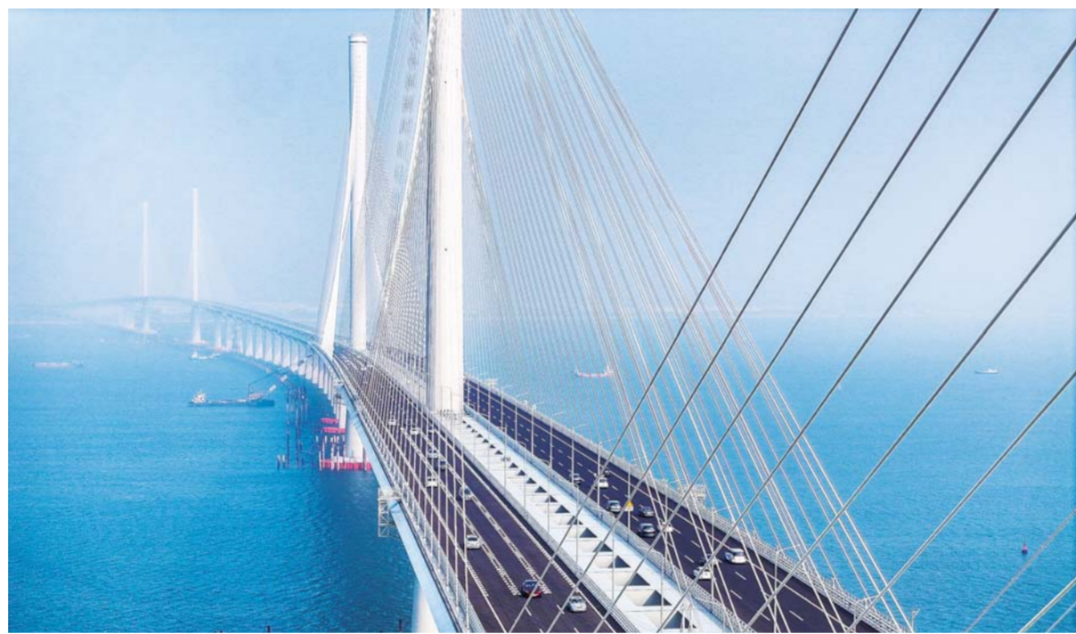
12月11日,黄茅海跨海通道正式通车后,车辆在黄茅海大桥上(无人机照片)。新华社记者 刘大为 摄
