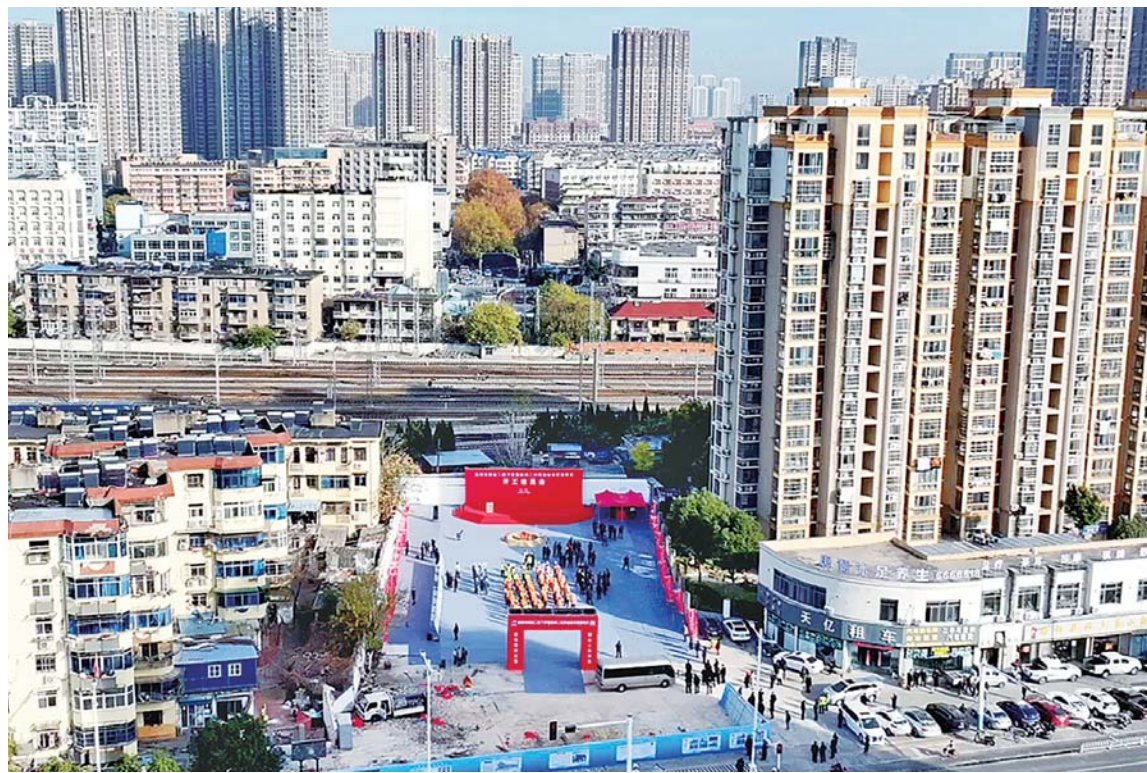
十二月九日上午,解放二路下穿京沪铁路蚌埠站工程开工动员会现场。融媒记者 陈昂 摄
