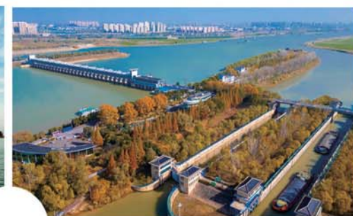
蚌埠闸扩建工程
