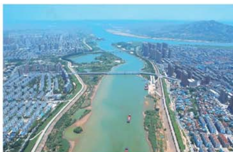
淮北大堤加固工程
