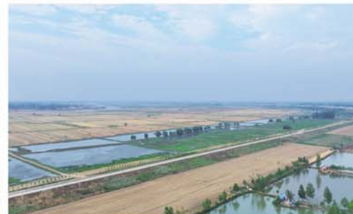
淮干王临段工程
