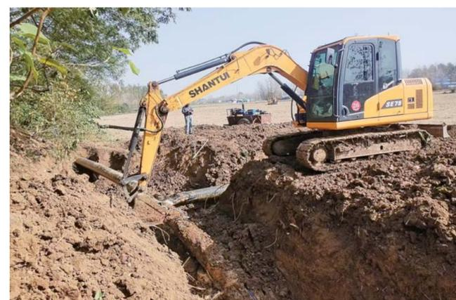
当前，固镇县各乡镇掀起冬修农田水利热潮，图为固镇县店村十多台大水利机械正在清沟筑渠、埋桩浇排水管，为明年夏粮丰收打下基础。
