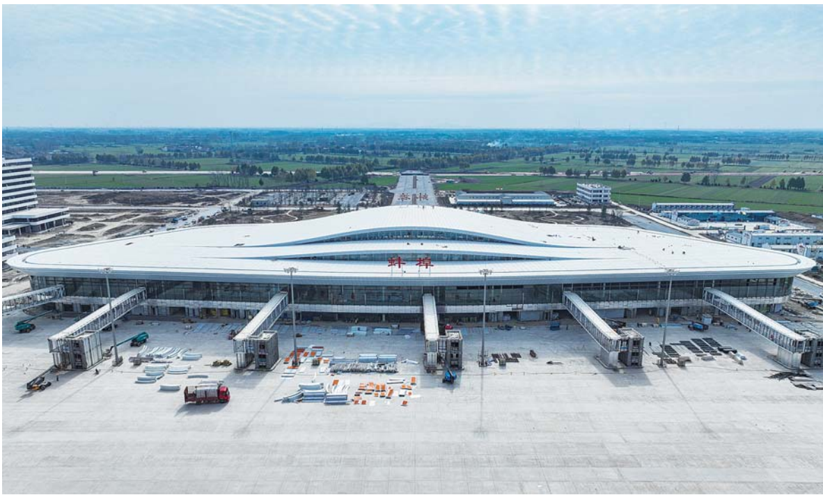
正在建设中的蚌埠滕湖机场。
