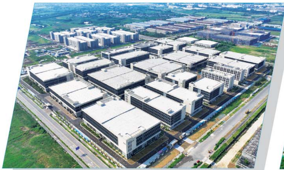
经发集团硅基制造中心新型显示产业园
