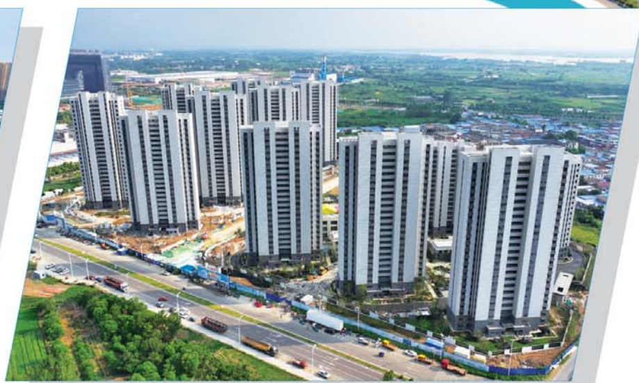
集安安置房项目
