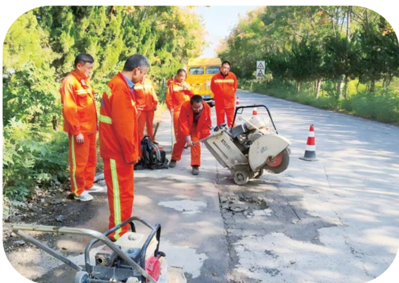
公路养护人员修补路面坑槽。
