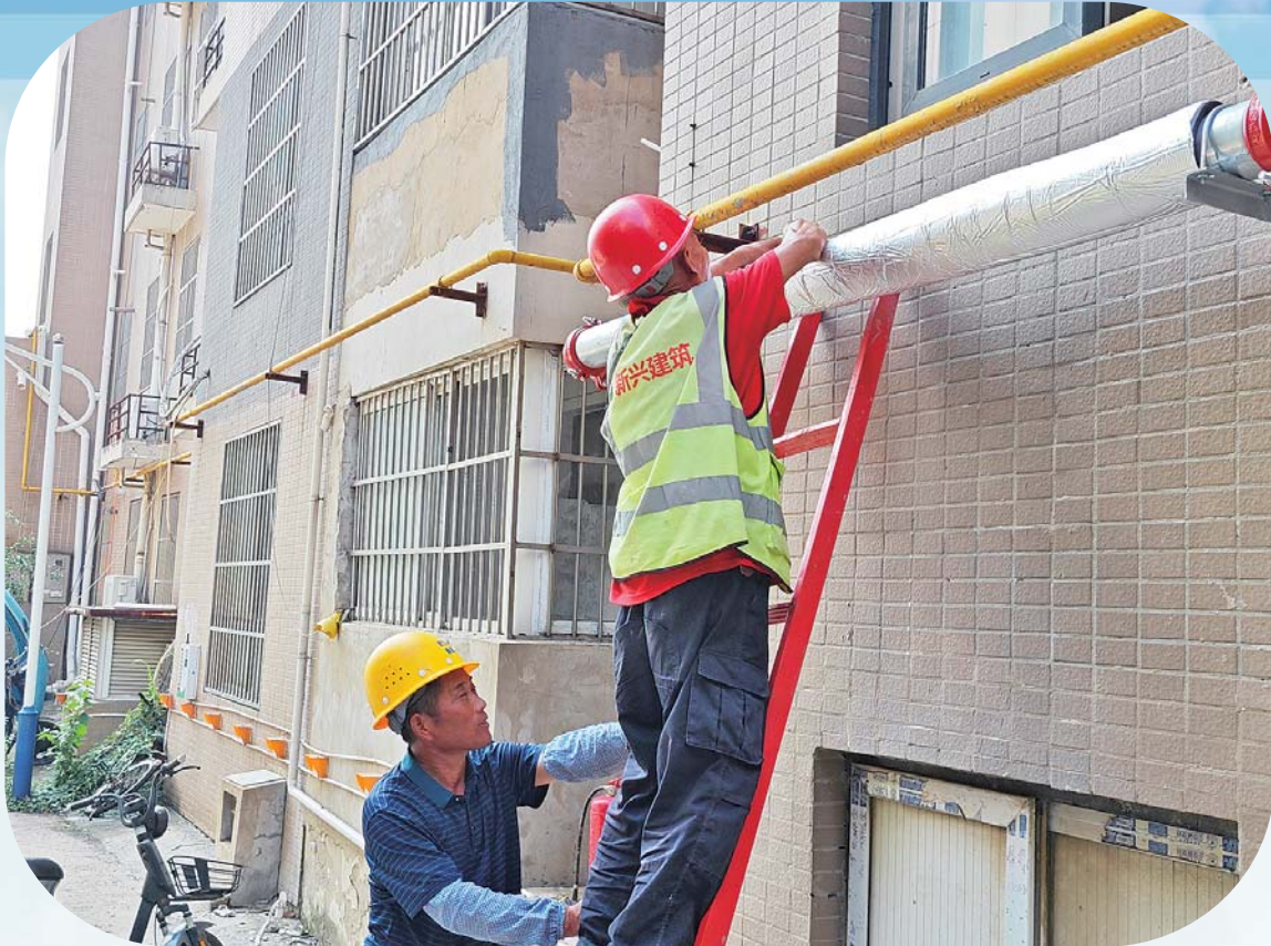
施工人员对消防管道进行覆膜。
