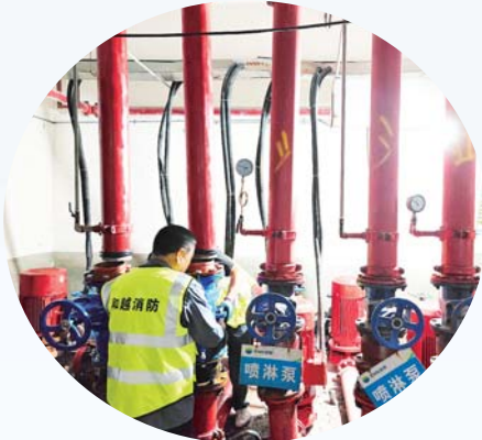
施工人员对消防泵房设备进行检修维护。
