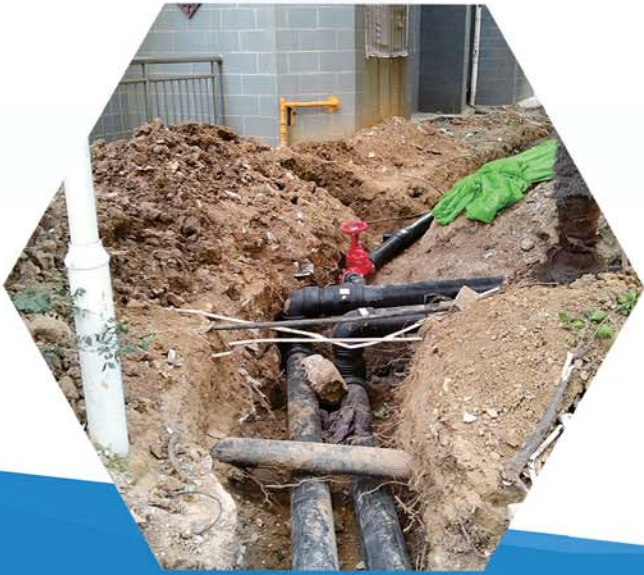
中心花园消防施工改造现场。
