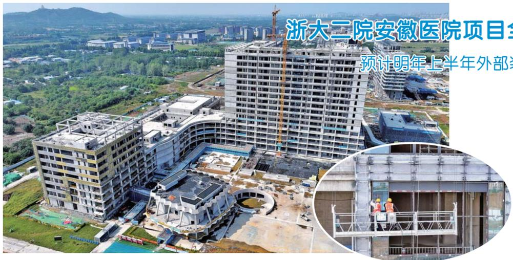
10月10日,浙大二院安徽医院项目施工现场,建筑工人按作业要求进行外墙保温和玻璃幕墙施工。该项目位于龙子湖区,学翰路以西,学苑路以南,规划G21路以东,规划D-7路以北,占地面积约135亩,总投资约15亿元,总建筑面积为19.2万平方米。据介绍,目前项目已全面进入装饰阶段,正在进行外墙保温和玻璃幕墙施工,预计明年上半年外部装饰施工完成,下半年内部装饰基本完成。
