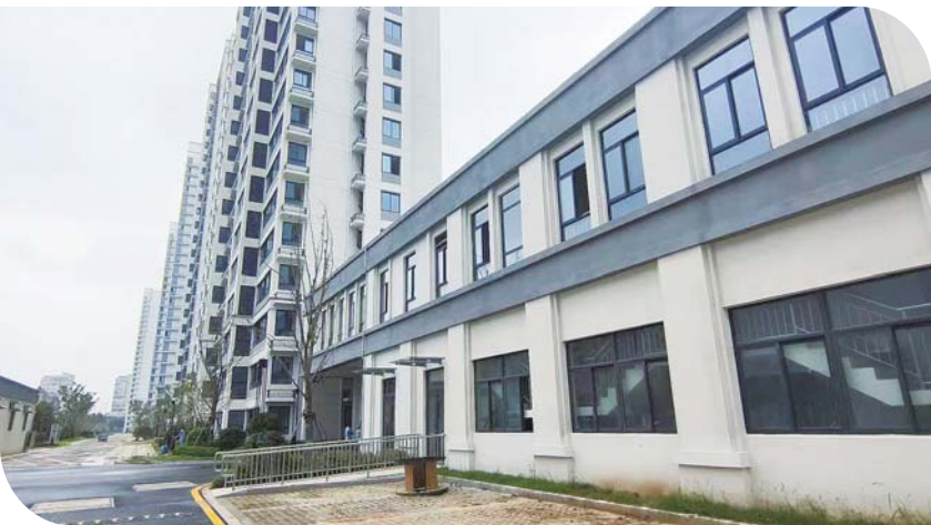
东航嘉苑小区已经完工,各类设施基本安装完毕。
