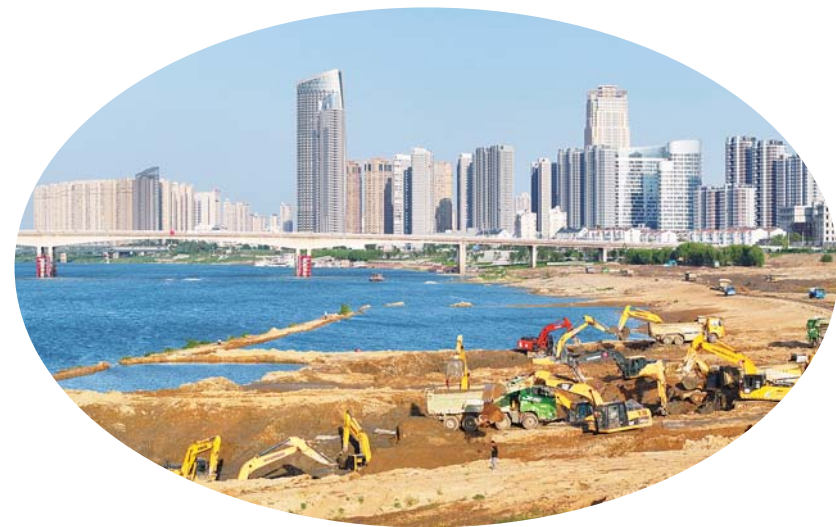
靓淮河工程(席家沟—朝阳路桥段)施工现场。
