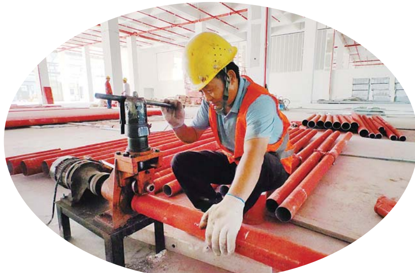
施工人员切割风管。
