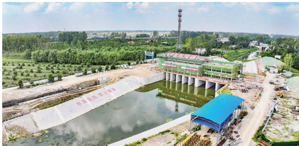
包集红星闸站工程施工现场。融媒体记者 陈昂 摄
