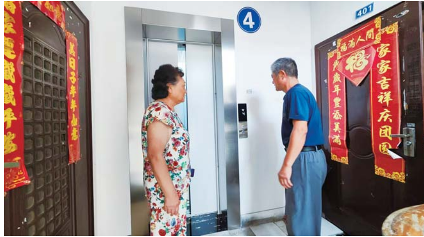
余庆苑小区某单元，全新的电梯已经更换完毕。
