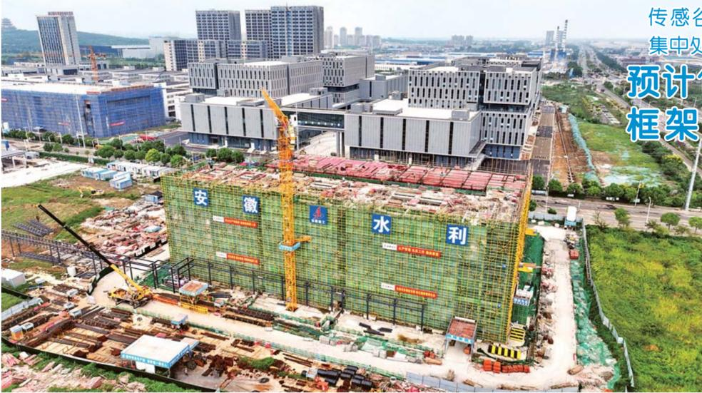
9月22日,传感谷八寸线配套生产废水集中处理站EPC项目现场一片忙碌,建筑工人正在抢抓进度冲刺节点。该项目位于蚌埠经开区中国传感谷园区东南角,主要包含项目厂房主体、内外装饰装修、园区内道路等所有主体工程,以及景观亮化、绿化、道排管网、强弱电、供水、围堵、智能化等所有配套及亮化工程。据介绍,目前本项目正在进行北侧二层水池及三层框架结构建设,预计10月份完成主体结构及框架砌体结构建设。
