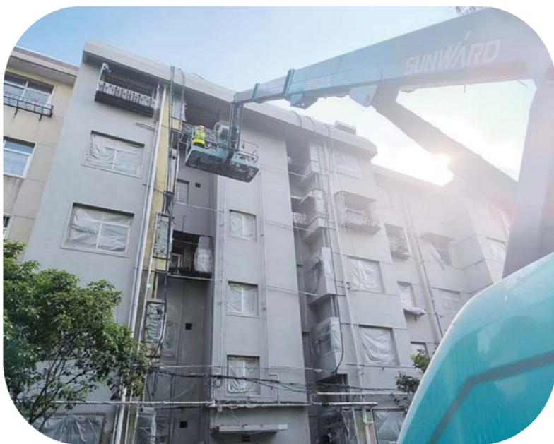
禹会区燕山路1053号院老旧小区改造项目施工过程中。
