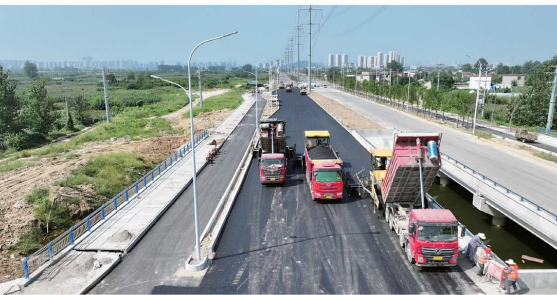
日前,治淮东路施工现场,施工人员正配合工程机械进行路面沥青摊铺。治淮东路系蚌埠临港产业园基础设施建设(一期)项目内容之一,除此还有8条市政道路,其中4条为新建项目,施工内容为管廊、车行道、人行道、雨污水管道、桥梁等及配套设施。据介绍,目前已有5条道路完工,预计年底前治淮东路、黄泥山西路等3条道路通车放行。
