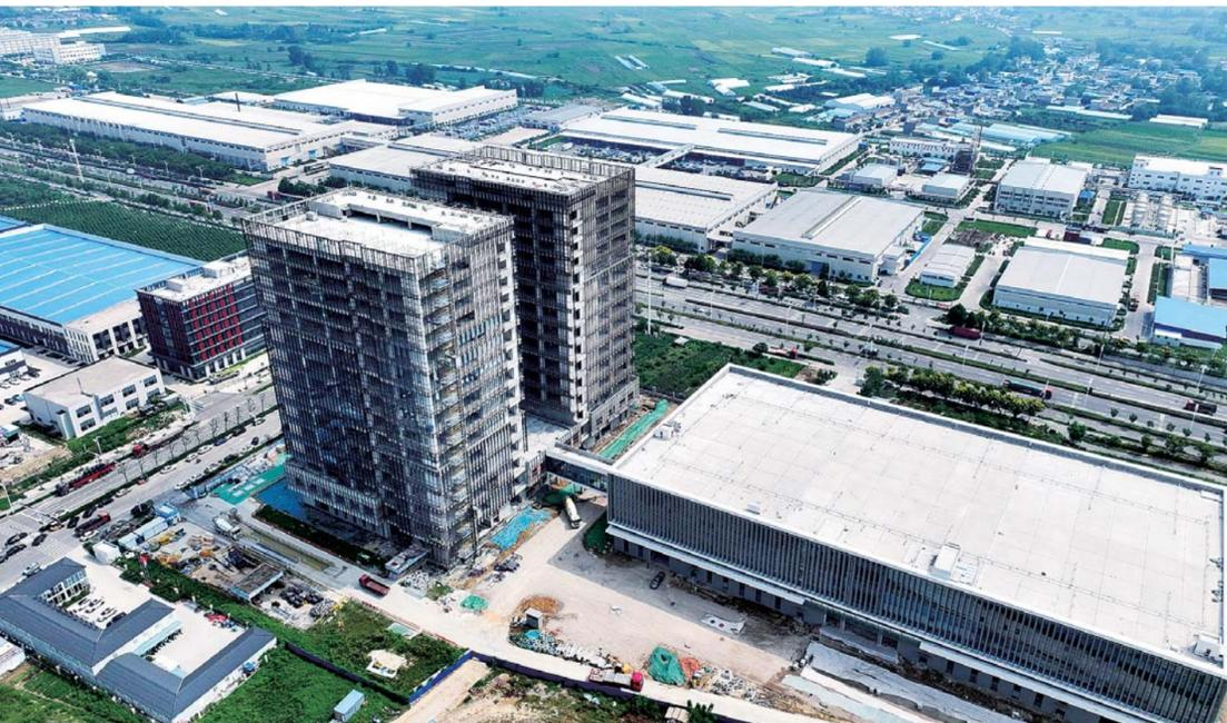
9月5日,临港科创园项目园区已经形成规模,落户企业在厂区内调试安装设备。该项目位于临港南环南侧、中环路西侧,工程总投资约38397.48万元,总用地面积约36203.7平方米,总建筑面积约106353.61平方米。目前,项目厂房1正在进行外立面玻璃幕墙安装,室内装修装饰及水电路风安装施工,厂房2已经竣工验收,预计12月底项目全面完工,投用后将作为一个集生产、研发及办公为一体的综合性产业园。
