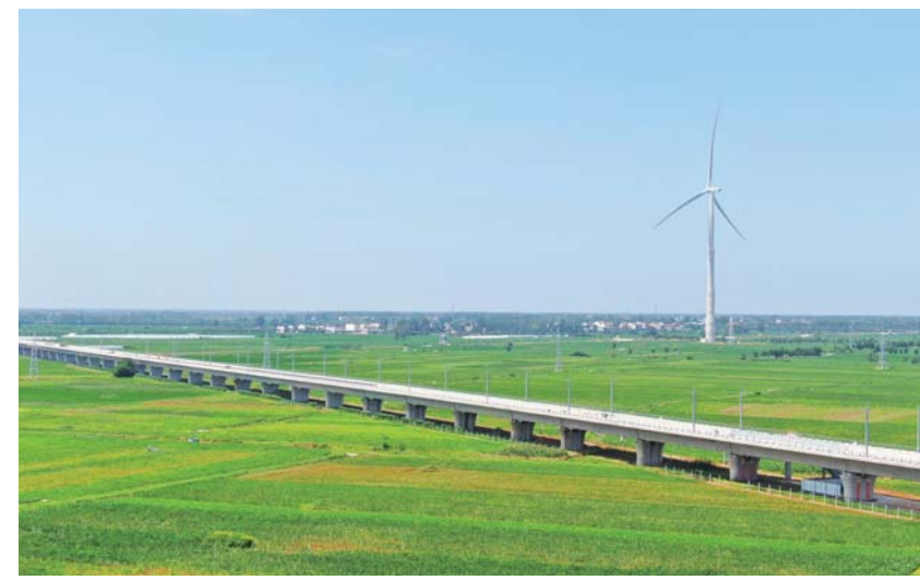
8月28日,中铁十五局合新铁路安徽段站前二标怀洪新河特大桥无砟轨道首件工程一次性顺利通过验收。
