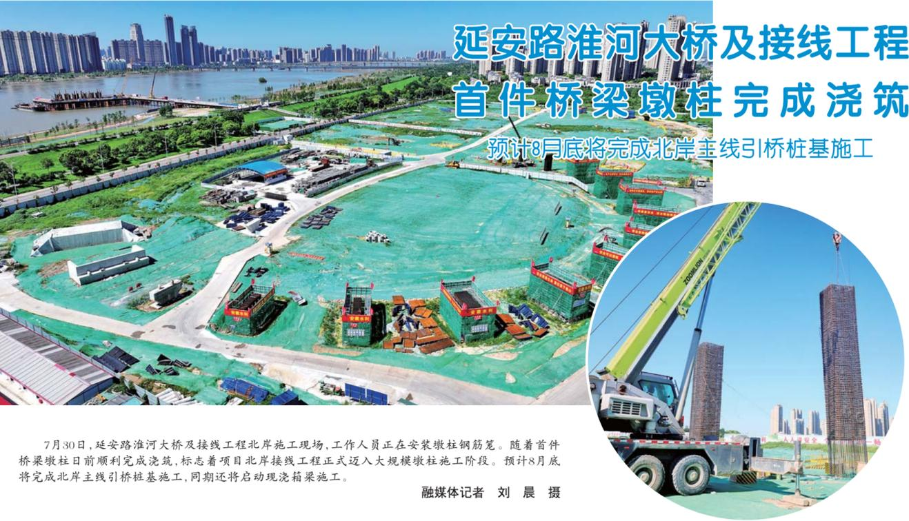
7月30日，延安路淮河大桥及接线工程北岸施工现场，工作人员正在安装墩柱钢筋笼。随着首件桥梁墩柱日前顺利完成浇筑，标志着项目北岸接线工程正式迈入大规模墩柱施工阶段。预计8月底将完成北岸主线引桥桩基施工，同期还将启动现浇箱梁施工。
