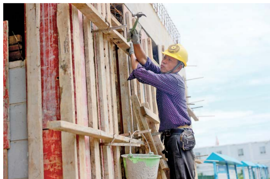
7月19日，蚌埠三中新校区项目现场，建筑工人按照施工要求作业。
