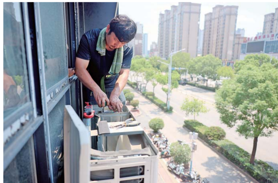
7月24日，空调安装维修工刘响身绑安全带检修空调。
