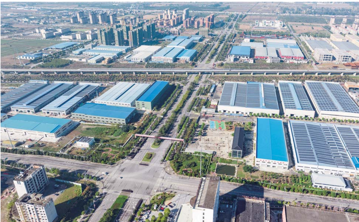
蚌埠产业合作园区（无人机照片）。融媒体首席记者 陈昂 摄
